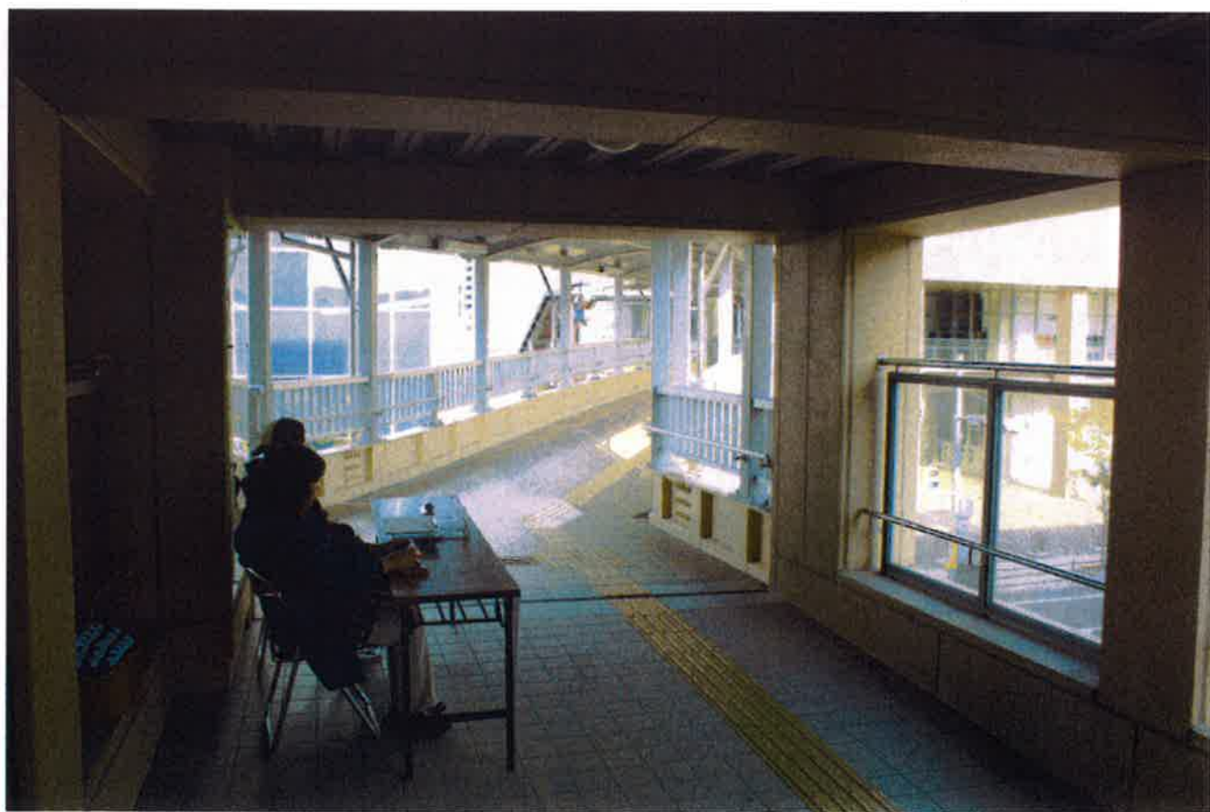
S t.6 コア・よかどう 国分中央歩道橋
